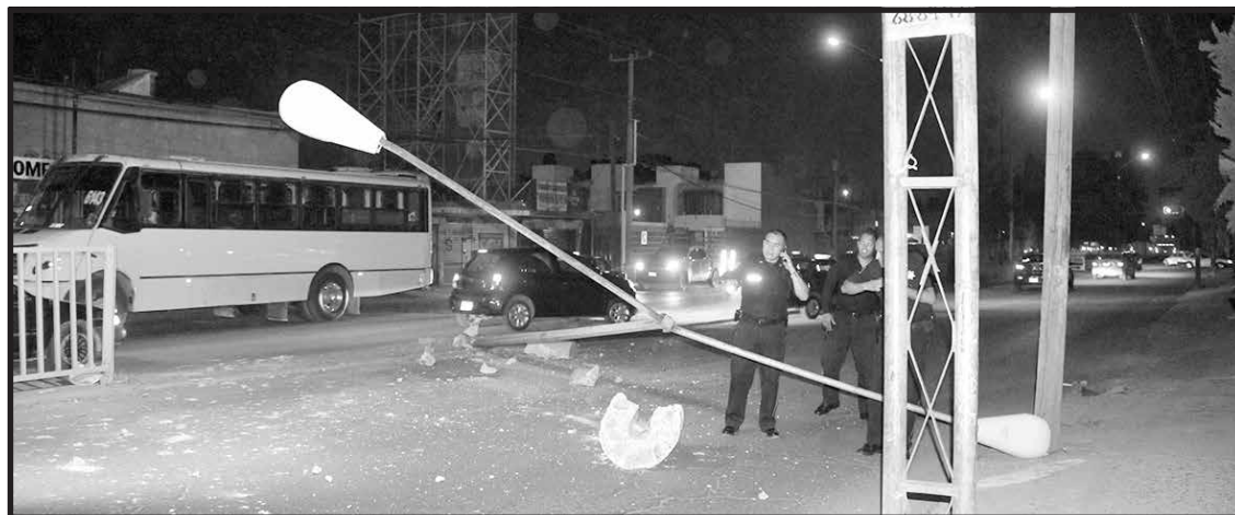
DAÑOS. Conductor de camión urbano perdió el control de la unidad y ascendió al camellón central e impactó contra una base de concreto derribando el poste. (Teodoro Blanco-SLH)
